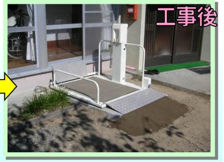
犬走りなどのコンクリート段差がある場合、そのコンクリート面にあった平滑な面が必要です。通路全体をコンクリートで工
