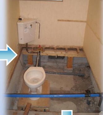
便器設置・配管工事
