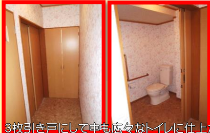
3枚引き戸にして中も広々なトイレに仕上がりました
