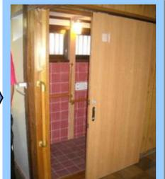
壁を破って引き戸新設! 春より介護保険対象工事です。
