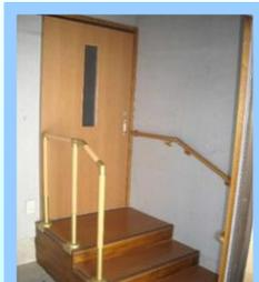
引き戸に変更し段差解消階段・手すり設置をしました。
