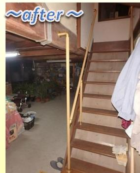
通常の壁付けの手すりではなく支柱などを使用し組立てる、組立手すりをご紹介させていただきます。立体的に制作できるのでイメージ次第でいろんな形状を造ることができます♪
