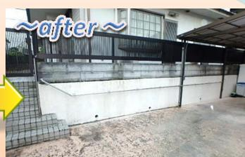
何の変哲もない壁付けの屋外手すりのように... この柱をかわすために出幅を出しています!
