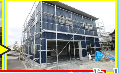
塗装をしてから、屋根・外壁取付
