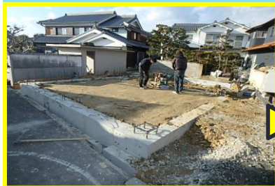
型枠を外して土を固めませ
