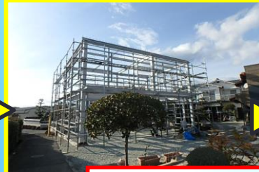
塗装をしてから、屋根・外壁取付
