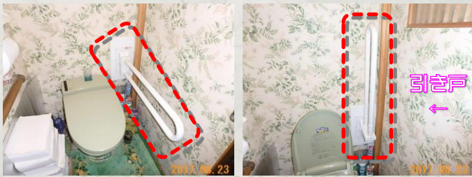
内側引き戸で壁に手すりが取付出来ない為、跳ね上げ手すりを取り付けました。
