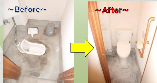
和式の水洗便器を洋式水洗便器に入替ました。隅付タンクも撤去し、向きも変更、手すりも取付ました。
